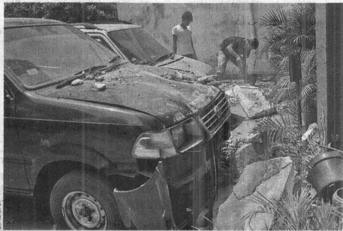
Pekerja membersihkan puing sisa reruntuhan kanopi beton gedung Program Studi Kenotariatan Unpad, Jalan Cimandiri, Kota Bandung, kemarin. Dalam insiden tersebut, empat mobil rusak tertimpa reruntuhan.
