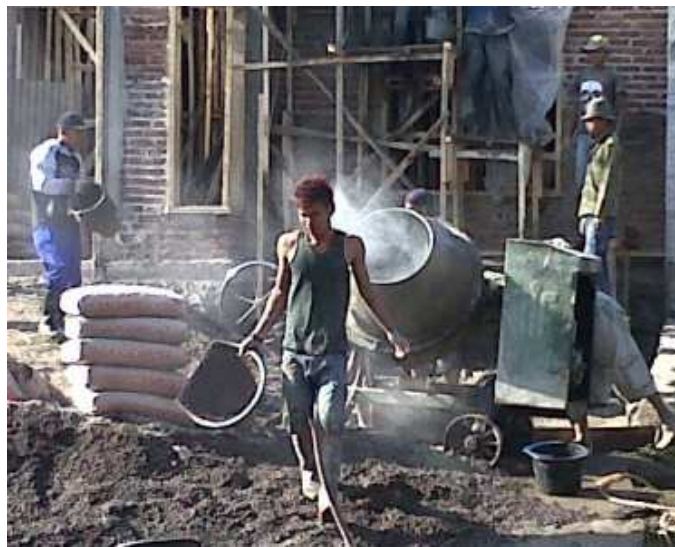
Gambar 32 TUKANG BANGUNAN YANG SEDANG MENGECOR DI CIKERUH – JATINANGOR
